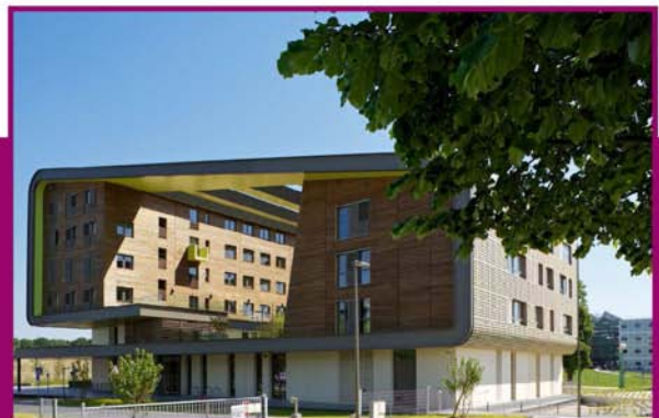
Bâtiment Coriolis © Caroline Rose - École des Ponts ParisTech
