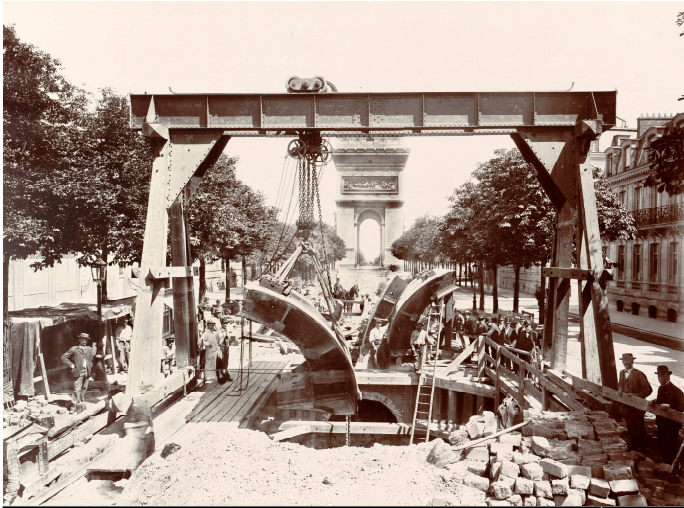
Avenue Kléber. Descente des pièces du bouclier du 11 ème lot. 17 juin 1899 | PH 451-2 A.5
