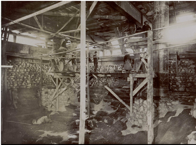
Viaduc d'Austerlitz. Chantier intérieur. 1904 | PH 451-13 A.8
