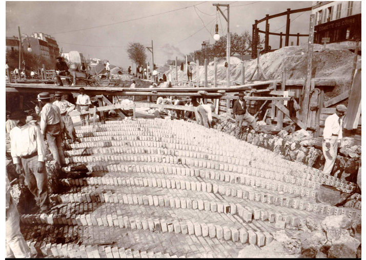
Station Porte de Vincennes (côté du départ) Briquetage de la voûte. 15 septembre 1899 | PH 451-3 A.2
