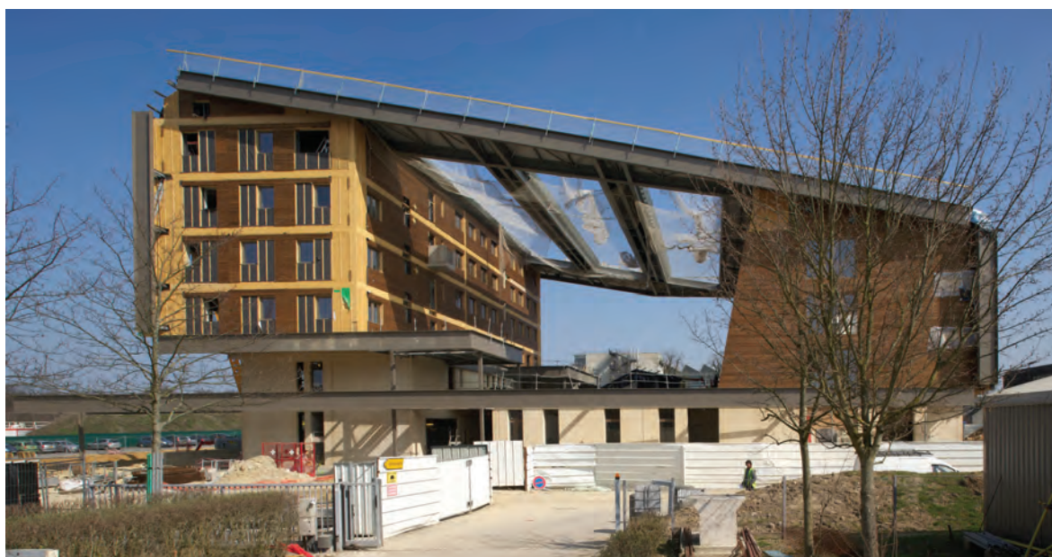
Chantier du bâtiment Descartes+
